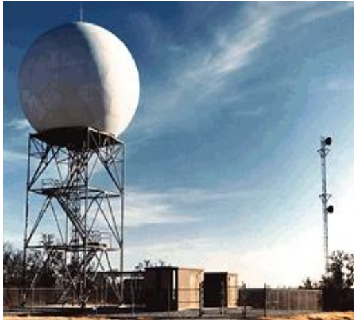
الصورة (6) تبين الرادار الذي يعمل بالأمواج النبضية.
